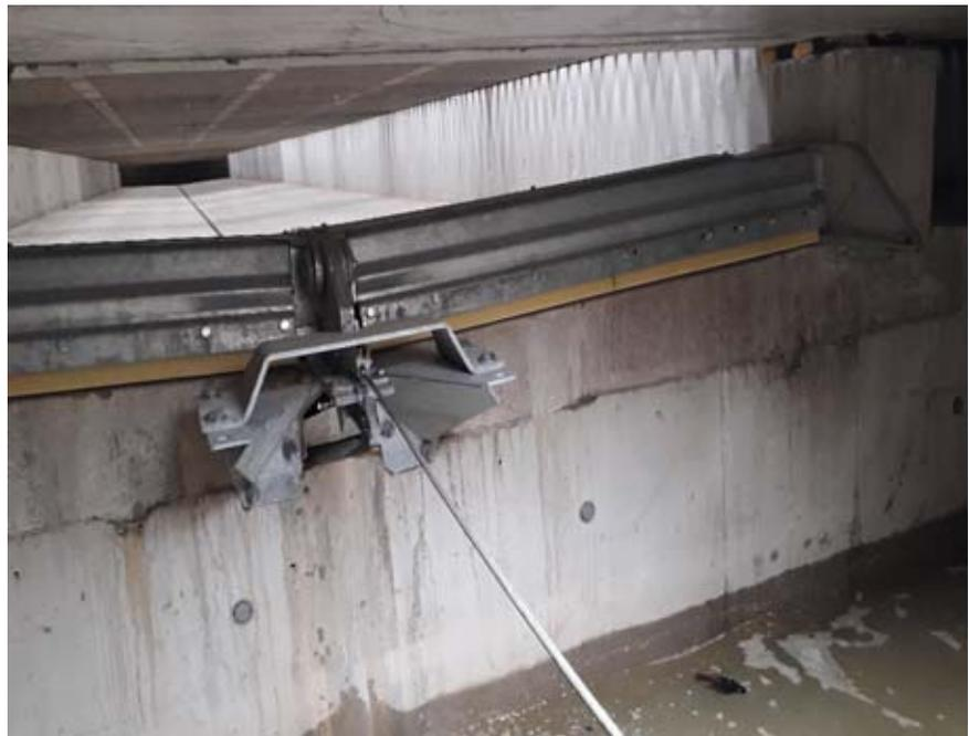
Blick in den Kanal einer Unterflurschieberentmistungsanlage – Abwurfkante.
