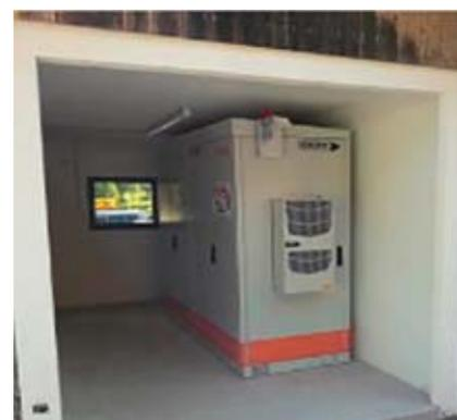
Ein Stromspeicher wird mit den nicht abgerufenen Überschüssen der betriebseigenen Photovoltaikanlagen geladen.
